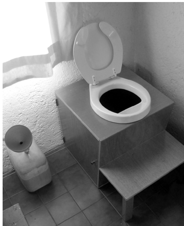
El cacajón con aditivos biocatalíticos a base de hojarasca, microorganismos y polvo de carbón vegetal. A un lado un mingitorio de garrafón con trampa de olores.
