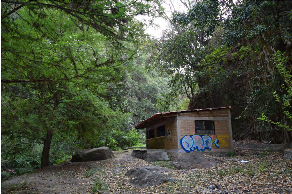
Foto 27. Instalación rústica abandonada, presuntamente destinada para servicios ecoturísticos.
